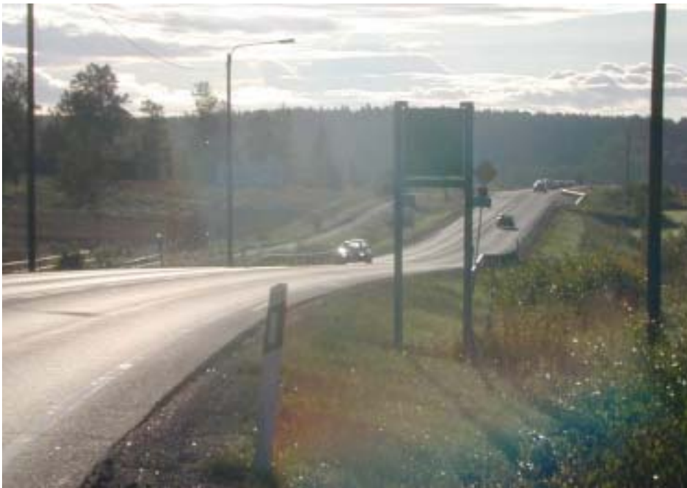
Kuva 5. Valtatiellä 1 varoituserkit asennettiin 50 ja 150 metriä nopeusrajoitusmerkin perään. Kuvassa näkyvä liikennemerkkipylväs poistettiin.
